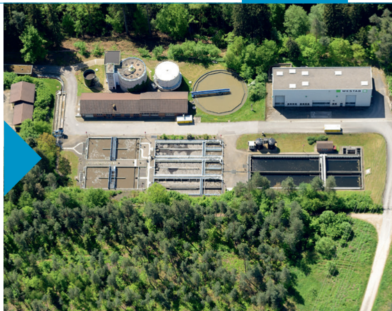
Dritter Umbau der Kläranlage
