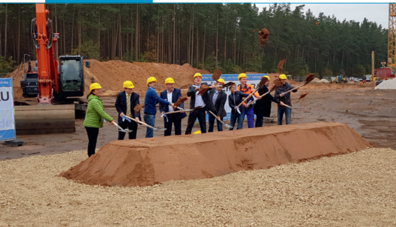
Spatenstich am 23. Oktober 2019
